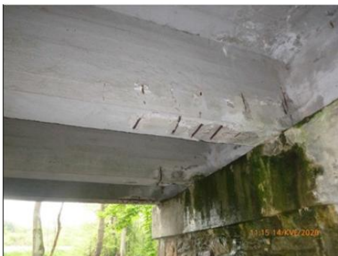
aktivní stékání vody na opěře 2 a obnažená výztuž NK
