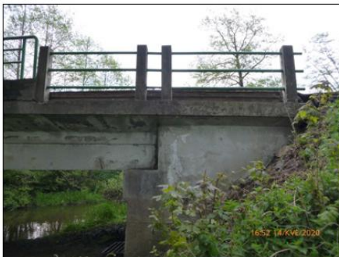
Nízké zábradlí. Niveleta vozovky až 400mm nad římsou! Nebezpečné ukončení mader zábradlí.
