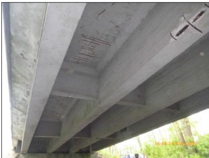
koroze výztuže desky mezi trámy 3 a 4
