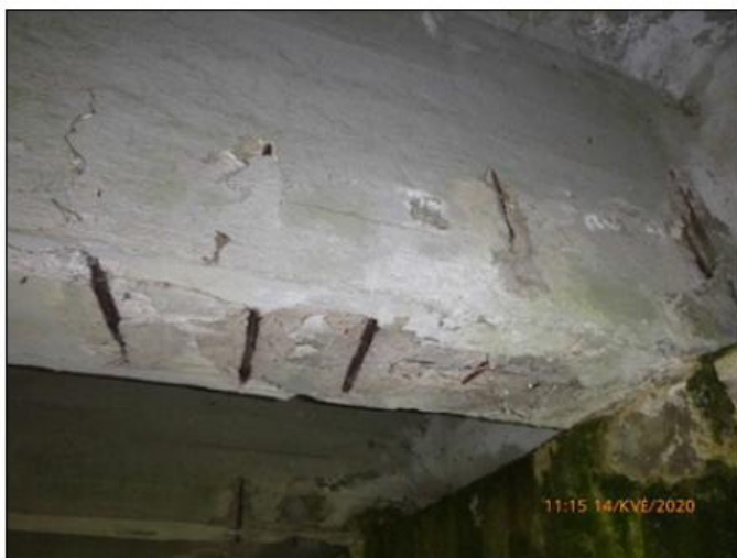
Obnažení výztuže trámů u opěr.
