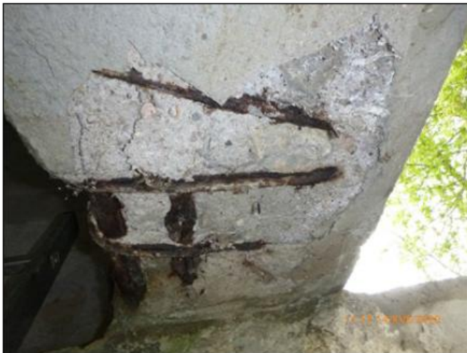
Obnažení výztuže trámů u opěr.
