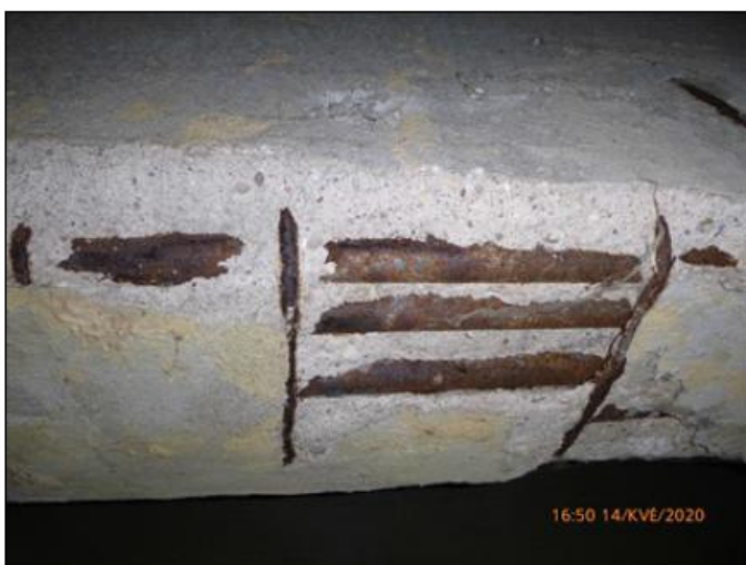
Obnažení výztuže trámů u opěr.
