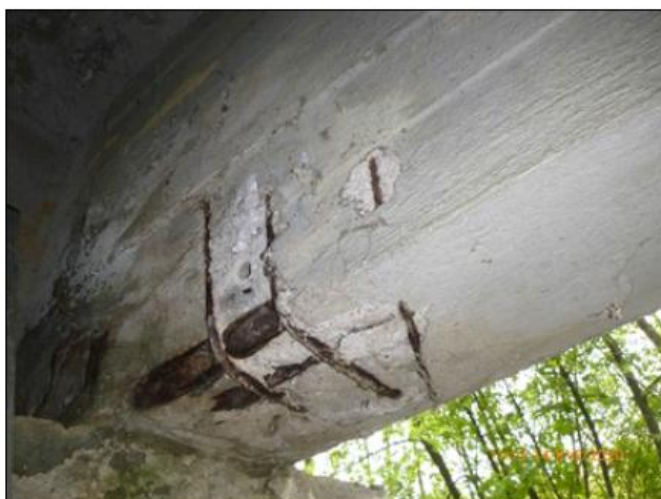
Obnažení výztuže trámů u opěr.
