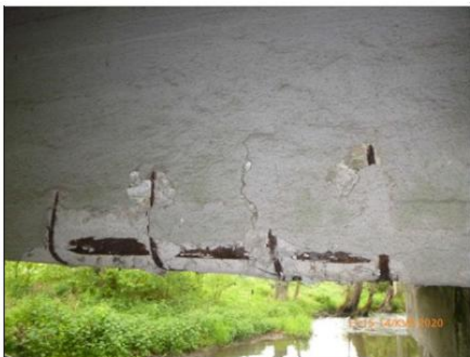
Obnažení výztuže trámů u opěr.
