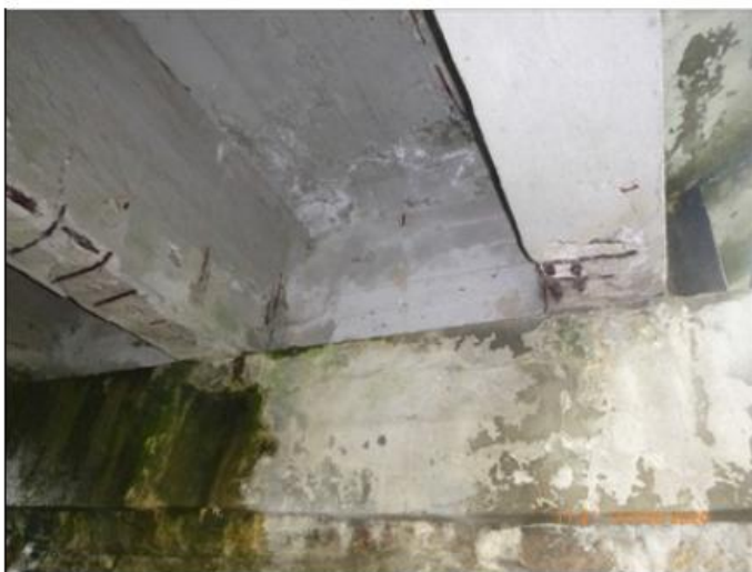
obnažení výztuže trámů u opěry 2
